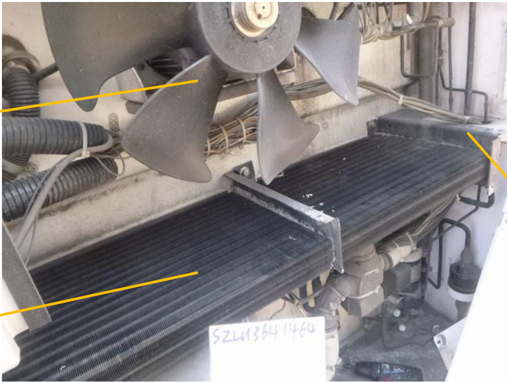
Fan - condenser motor FKN
